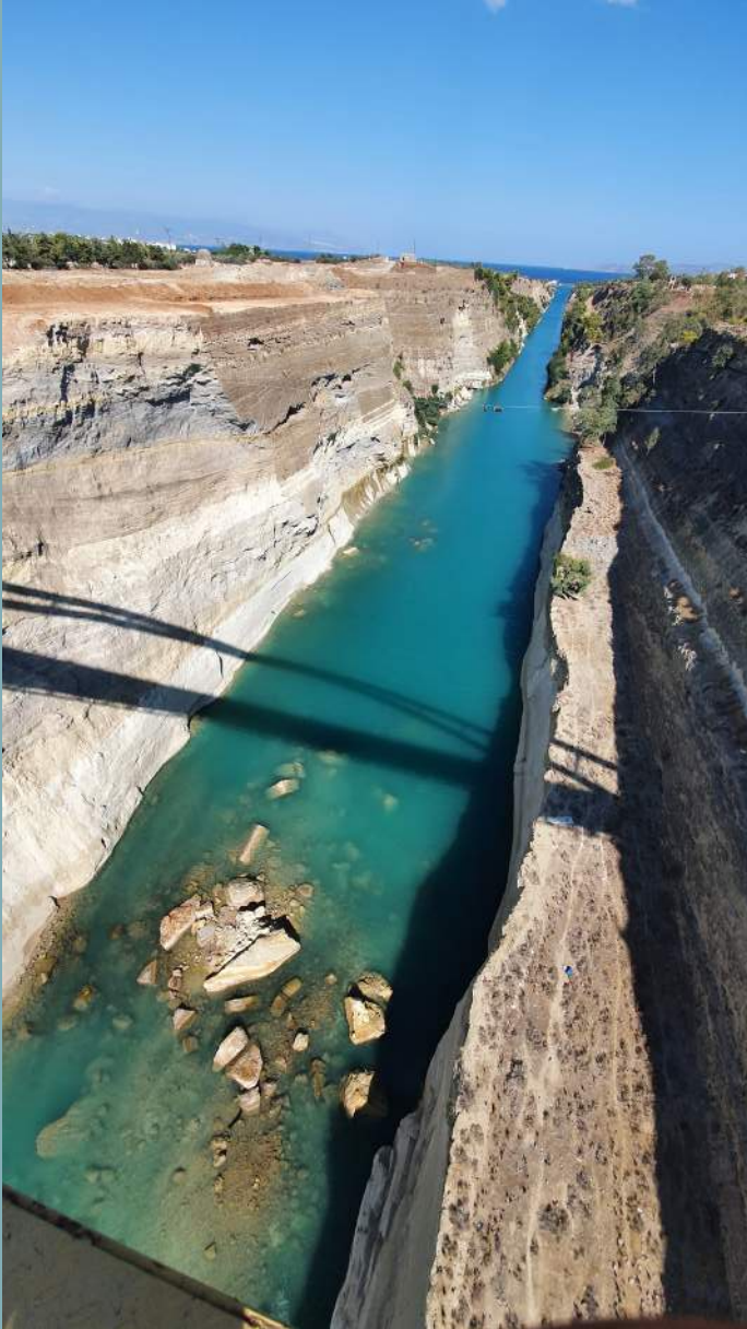
Agosto 2021, situazione frana
